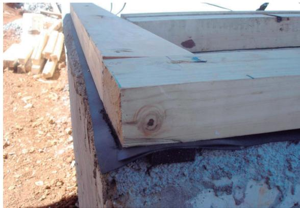
Figura 10.25: sello bajo solera incluye un Compriband (marca Rothoblaas)
