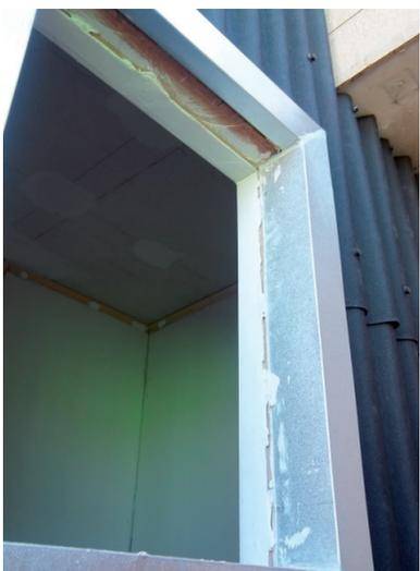
Figura 10.14: Sellos de poliuretano inyectado en marcos de ventanas
