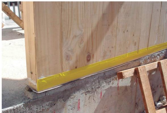
Figura 10.26: Cintas de sello en unión entre solera y panel
