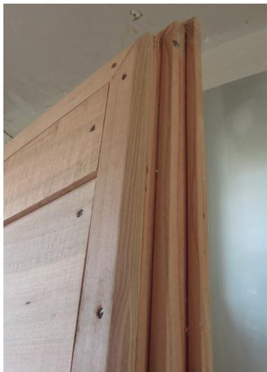
Figura 10.37: Puerta de acceso de madera con doble contacto
