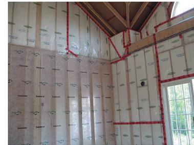
**Figura 7.6:** Sello de hermeticidad al aire en unión entre marco de puerta y muro.
