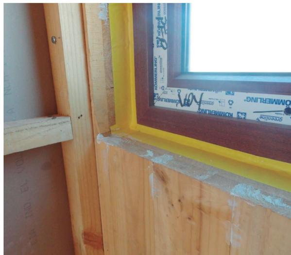
*Figura 10.33: Sellos en unión marco-muro, por el interior*
