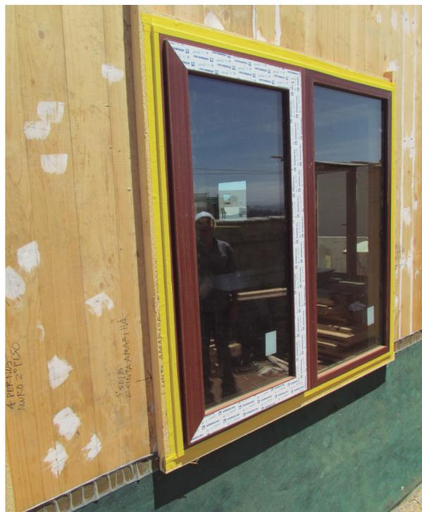
*Figura 10.34: Sellos en unión marco-muro, por el exterior*
