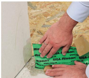
**Figura 7.4:** Encuentro entre placa de madera y pavimento de hormigón mediante sello con cinta adhesiva para mejorar hermeticidad al aire.
