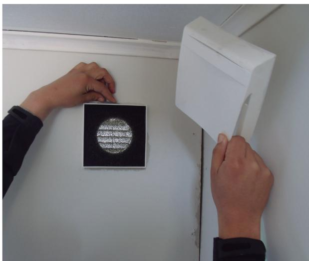
Figura 10.17: Aireadores operables en muros envolventes
