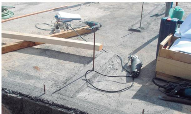
Figura 10.24: Bases de soleras niveladas
