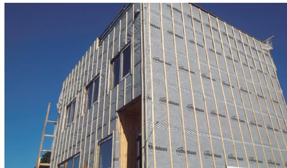
Figura 10.31: Membrana de barrera al viento
