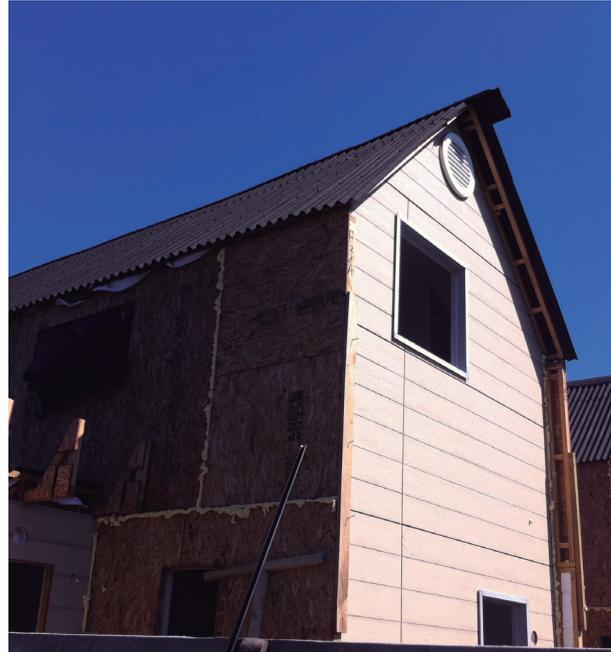
*Figura 10.11: Sellos de poliuretano inyectado en uniones entre placas de OSB*
